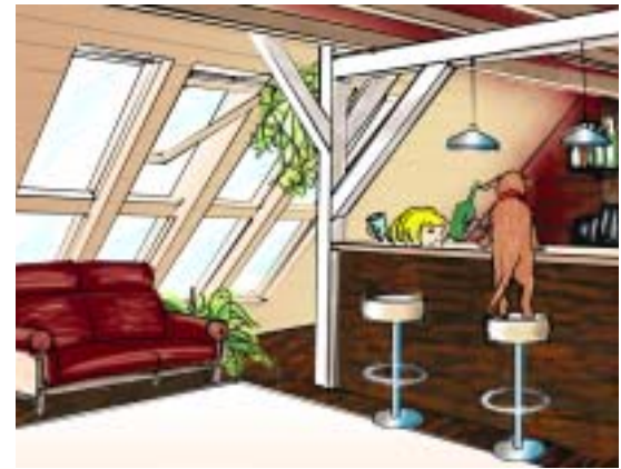
Tetőtér látszó fogópárokkal
